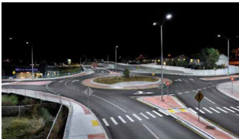
Exemplo de via iluminada com luminárias LED com emissão 4.000 K.
