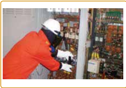
Figura 4 – Trabalho em ZR em circuito elétrico de baixa tensão
