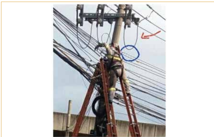
Figura 4 – Atividade em telefonia em Trabalhos em Proximidade com redes de distribuição de energia elétrica de AT de 13,8kV.
