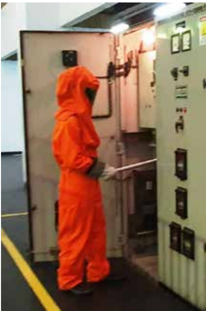
Figura 4 – Vestimenta para proteção arco elétrico Risco 4.
