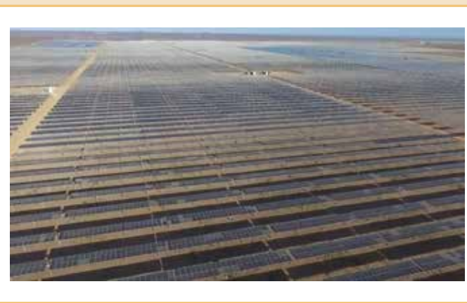
Foto aérea de local onde trabalhamos 72 Mwp
