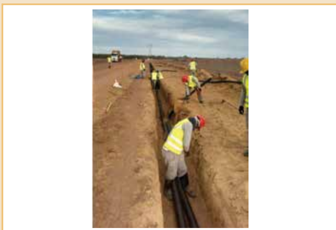
Construção de vala para lançamentos dos cabos
