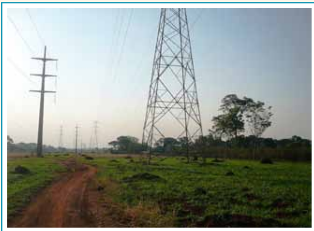
Figura 4 – Linhas de subtransmissão de padrões distintos, em Goiás.
