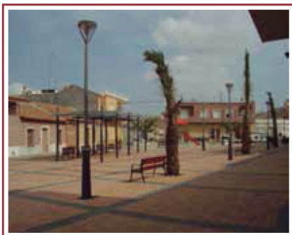
Foto 2 – Iluminação de áreas para uso de pedestres
