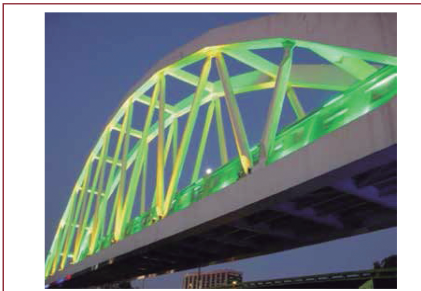
Foto 3 – Iluminação da estrutura de pontes
