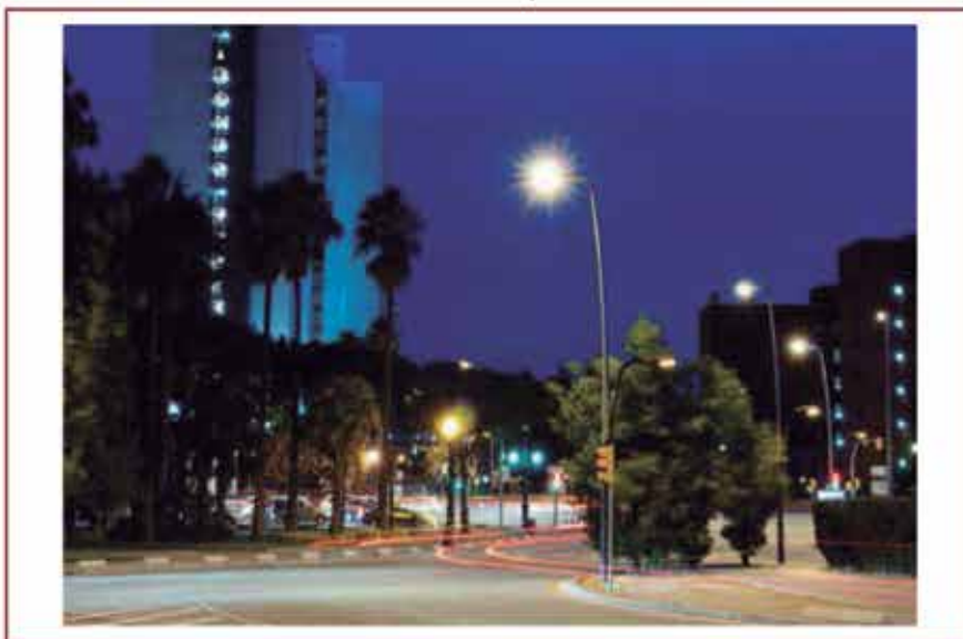
Foto 1 - Iluminação para via para veículos e para calçadas
