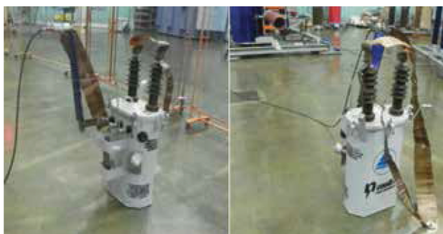
Figura 5 - Transformador de distribuição sob ensaio de Impulso atmosférico.
