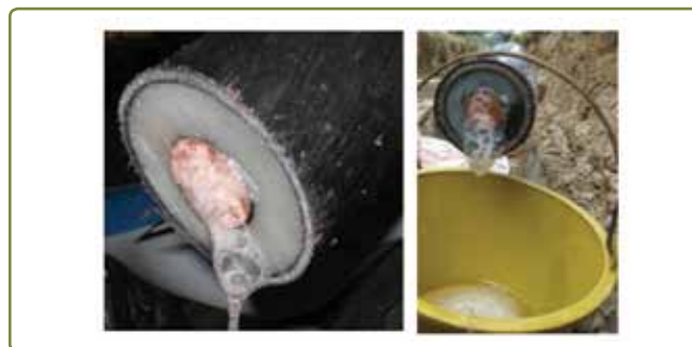
Figura IV: Cabos com água.
