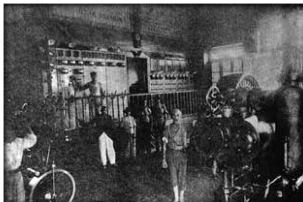
Figura 1 - Estação de Força e Fonte Luz Font: memórias da Eletrobrás
