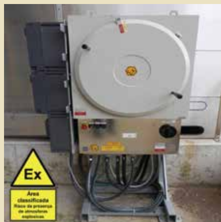
Exemplo de instalação de painel “Ex” para distribuição de circuitos de força e controle, em áreas classificadas contendo a presença de atmosferas explosivas, formadas por gases inflamáveis ou poeiras combustíveis.
