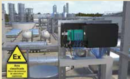
Exemplo de instalação de Switch de campo com padrão APL/2-WISE “Ex” em áreas classificadas contendo a presença de atmosferas explosivas, formadas por gases inflamáveis ou poeiras combustíveis.
