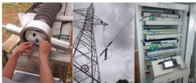
Figura 5 - Construção da RS em LT para testes na UniverCemig: (a) realização das emendas na base do isolador óptico e elétrico 138 kV, (b) instalação do arranjo com o condutor OPPC e (c) rack com as terminações das fibras ópticas e os equipamentos da rede óptica, CWDM e OTDR, na central de controle.
