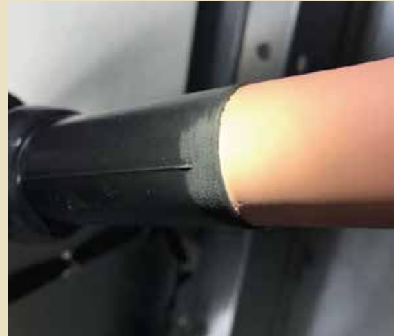
Figura 3 - Terminação com corte na semicondutora.
