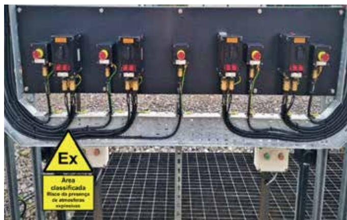
**Figura 1 - Exemplo de botoeiras locais de controle com tipos de proteção combinados Ex "db eb mb", instaladas em áreas classificadas, com a instalação de cabos de aterramento e de equipotencialização.**
