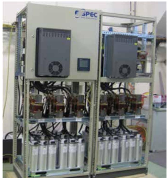
**Figura 6 – Sistema de compensação reativa com manobra sincronizada estática e reatores antirressonantes. Fonte: o autor.**
