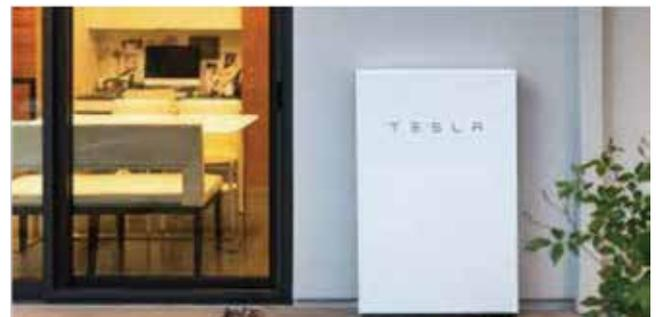
**Figura 4 – Sistema de armazenamento eletroquímico residencial.**
