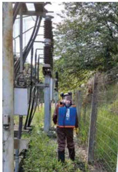
**Figura 1 - Atividade de limpeza com pessoa BA1 (comum) em subestação de alta tensão.**
