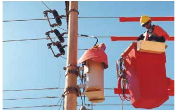
**Figura 5 - Atividade em linha viva MT - redes aéreas de distribuição de energia elétrica.**
