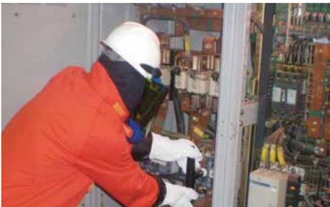
**Figura 3 - Atividade de manutenção elétrica BT “ao contato direto”.**
