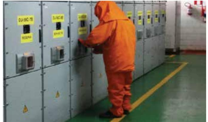
**Figura 4 - Atividade de manutenção elétrica MT “ao contato direto”.**
