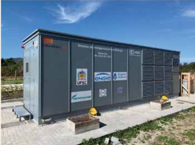
40 Figura 5 - Exemplo de projeto de P&D de bateria de segunda vida, localizado em Florianópolis (SC). Fonte: UFSC, NewCharge, entre outros.
