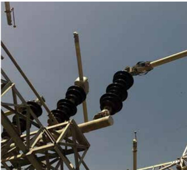
**Figura 5 – Chave seccionadora rotativa de dupla abertura lateral.**
