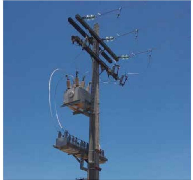
**Figura 8 – Banco de capacitores com religador à montante.**
