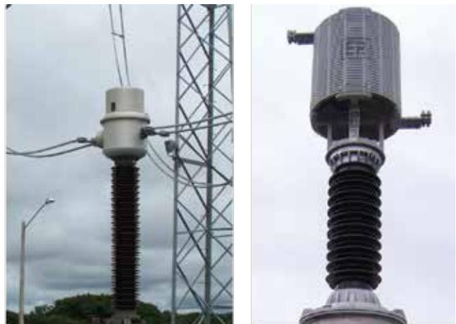
Figura 3 – Transformadores de instrumentos – TC à esquerda e TP à direita.
