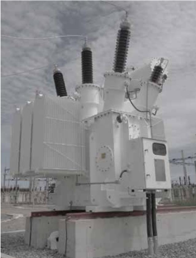
**Figura 7 – Reator de derivação.**
