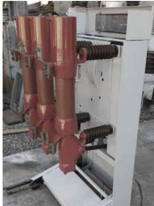
Figura 4 – Disjuntor de alta tensão do tipo PVO.
