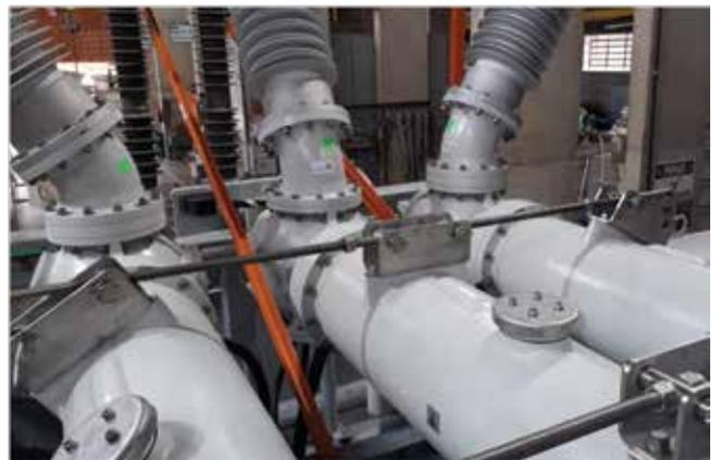
**Figura 6 – Módulo híbrido compacto instalado sobre subestação móvel.**
