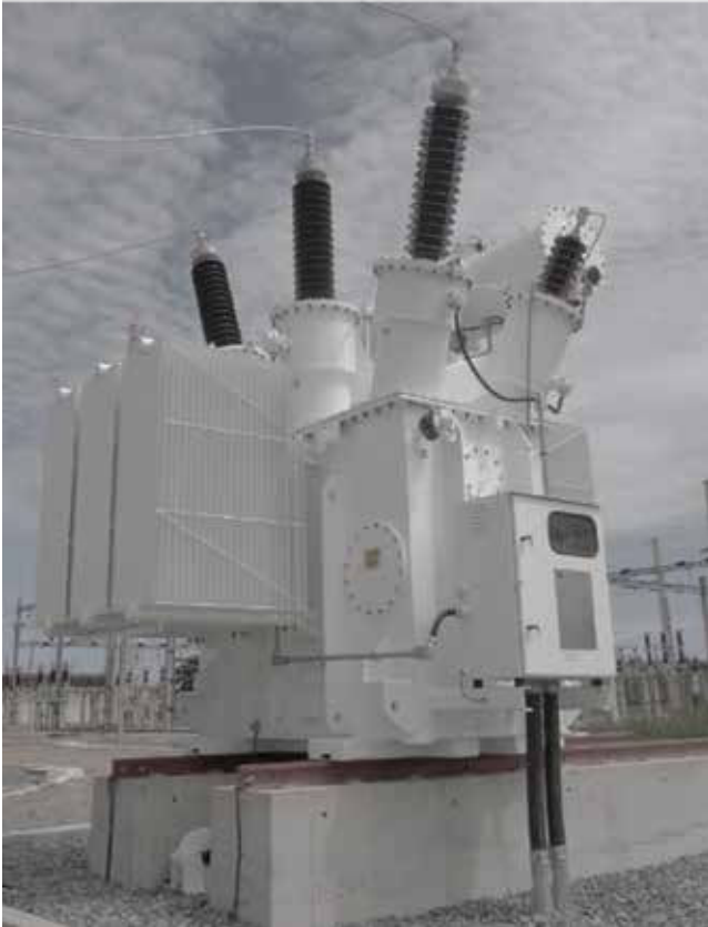
Figura 7 – Reator de derivação.
