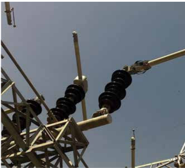
Figura 5 – Chave seccionadora rotativa de dupla abertura lateral.
