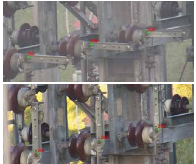
Figura 3 – Resultados obtidos pelo sistema sobre imagens de um conjunto de chaves reais, as quais tiveram seu estado alterado.
