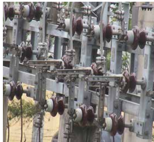
Figura 1 – Chaves seccionadoras do tipo “faca”.
