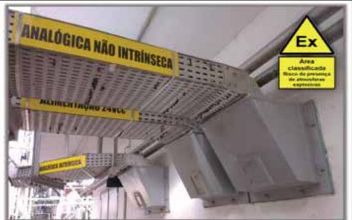
Exemplo de montagem de distribuição de cabos em áreas classificadas por meio de sistema de bandejamentos e leitos.
