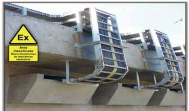
Exemplo de montagem de caixas de areia para passagem de cabos para circuitos de elétrica, instrumentação, automação ou telecomunicações em fronteiras entre áreas classificadas e áreas não classificadas.
