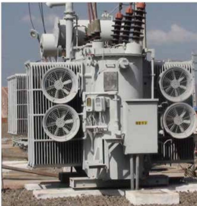
Figura 1 – Transformador com sistema de ventilação forçada.
