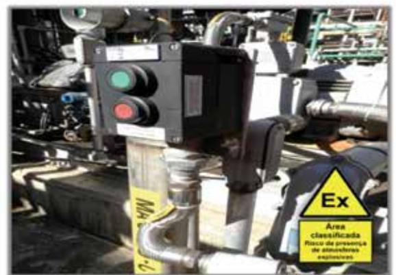
Exemplo de montagem de botoeira local de comando Ex “de”. Ao fundo, exemplo de instalação de motor de indução trifásico com marcações Ex “eb”, Ex “ec” ou Ex “tb”.
