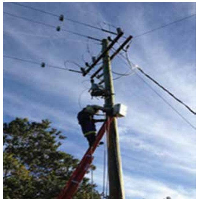
Figura 2 - Instalação dos equipamentos.
