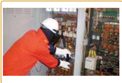
Figura 4 – Trabalho em ZR em circuito elétrico de baixa tensão
