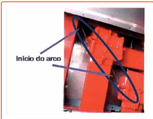
Figura 6 - Colocação do fio metálico, entre fases, usado para o início do arco.
