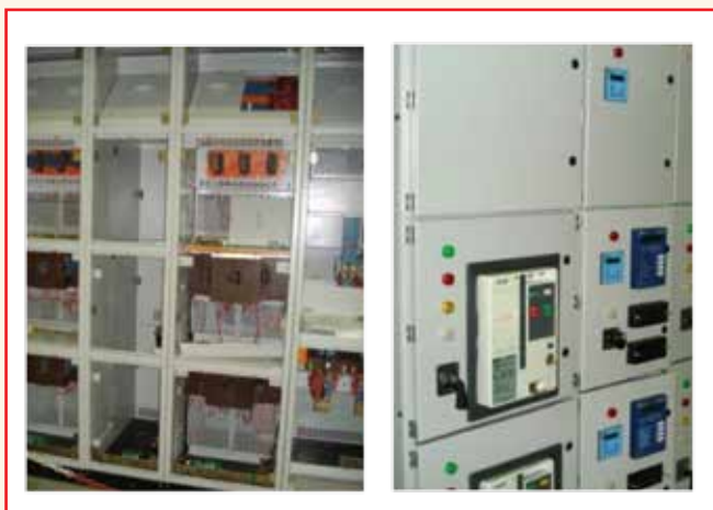
Figura 5 – CMCP-BT com forma de separação “4b” e proteção secundária.
