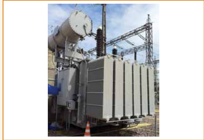
Figura 14 – Transformador 230-69-13.8 KV sob teste.
