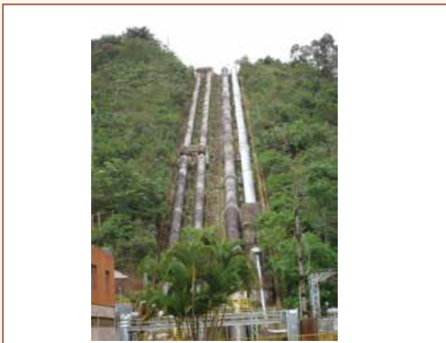
Figura 1 – Estação elevatória de água tratada.
