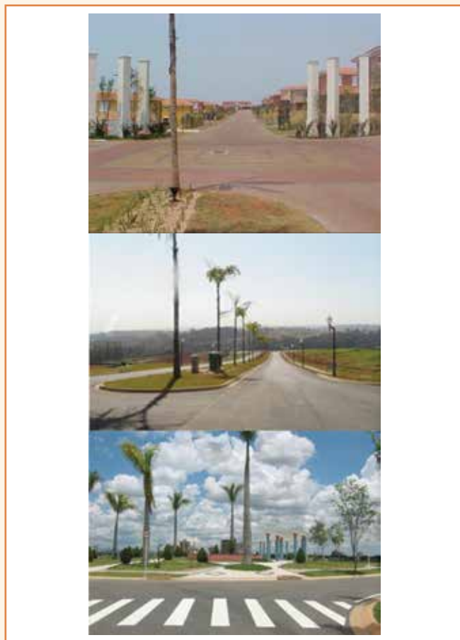
Figura 11 – Loteamentos e condomínios com redes subterrâneas.
