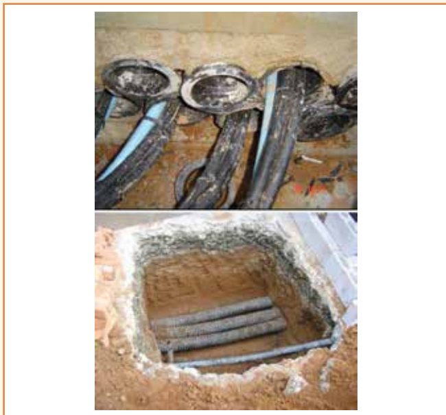
Figura 7 – Banco de dutos e dutos corrugados.
