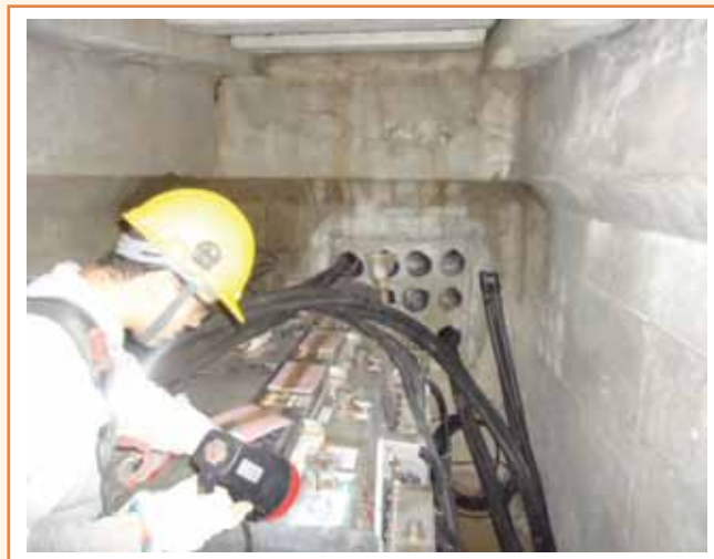
Figura 20 – Processo de instalação da chave automática.
