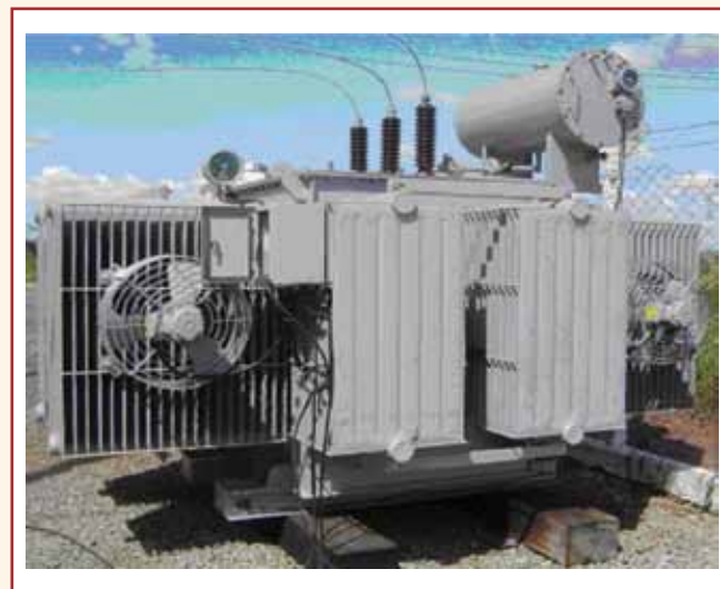
Figura 3 – Reator a núcleo saturado.
