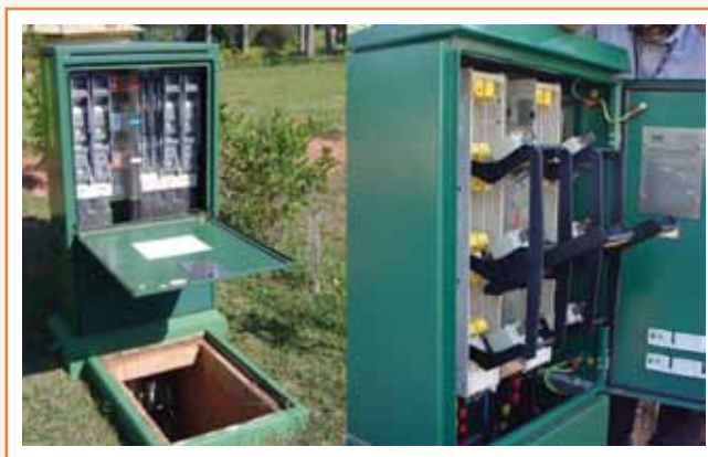
Figura 3 – Inspeção em quadros de distribuição em pedestal.
