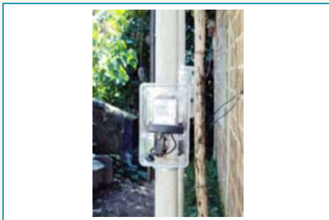
Figura 15 – Conector instalado dentro de caixa de policarbonato.
