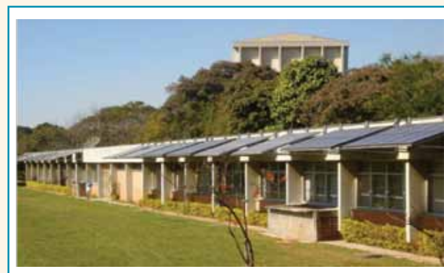
Figura 5 – Sistema fotovoltaico instalado no IEE-USP para alimentação do prédio de administração. [Fonte: IEE-USP]
