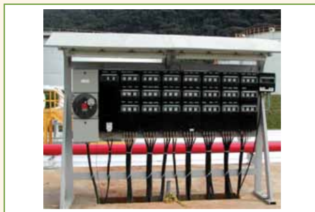
Figura 13 - Exemplo de montagem de painel de distribuição de circuitos força (440 V trifásico) com invólucros plásticos e componentes encapsulados de fábrica com proteção combinada Ex “de” Gb. Vantagens: dispensa a necessidade de invólucros metálicos, de unidades seladoras nas entradas de eletrodutos ou de prensa-cabos Ex “d” nos dispositivos de entrada de cabos. Fonte: Petrobras.
