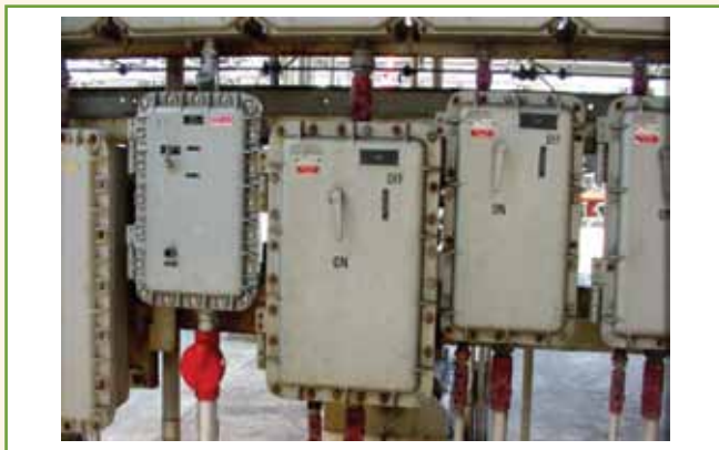
Figura 10 - Exemplo de montagem de painéis de força e comando com invólucros metálicos à prova de explosão com juntas planas e entradas diretas de cabos. Desvantagens: necessidade de grande quantidade de parafusos de fixação das tampas nos flanges e de unidades seladoras nas entradas de eletrodutos. Fonte: Petrobras/RPBC.
