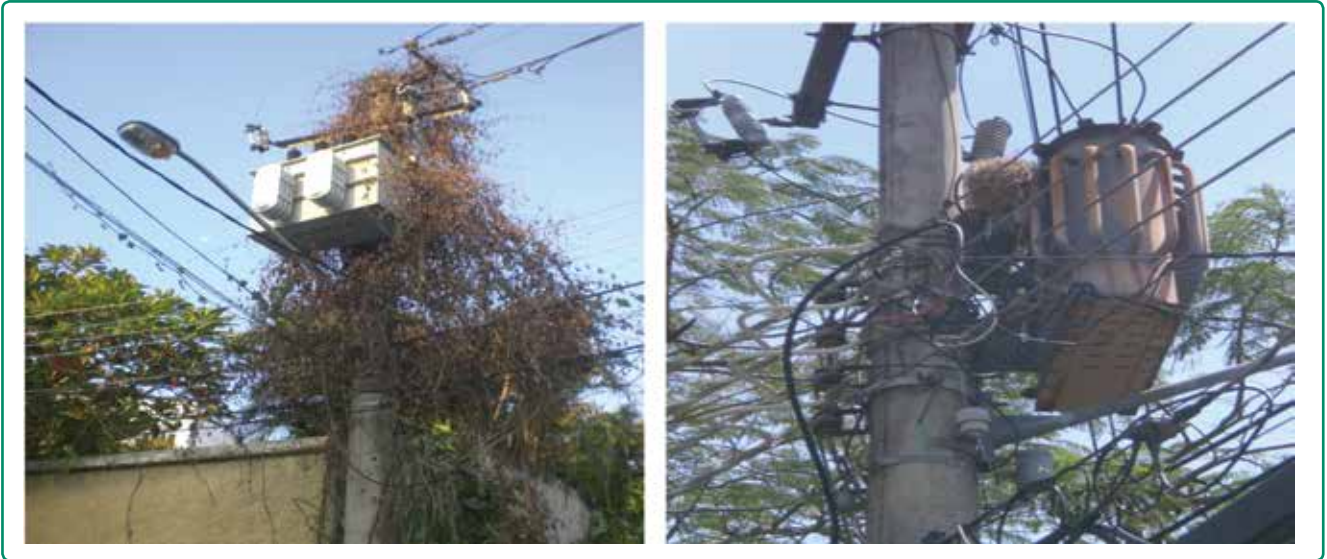
Figura 2 – Situações em que é fácil acontecer um curto fase terra durante um temporal causando sobretensões.
