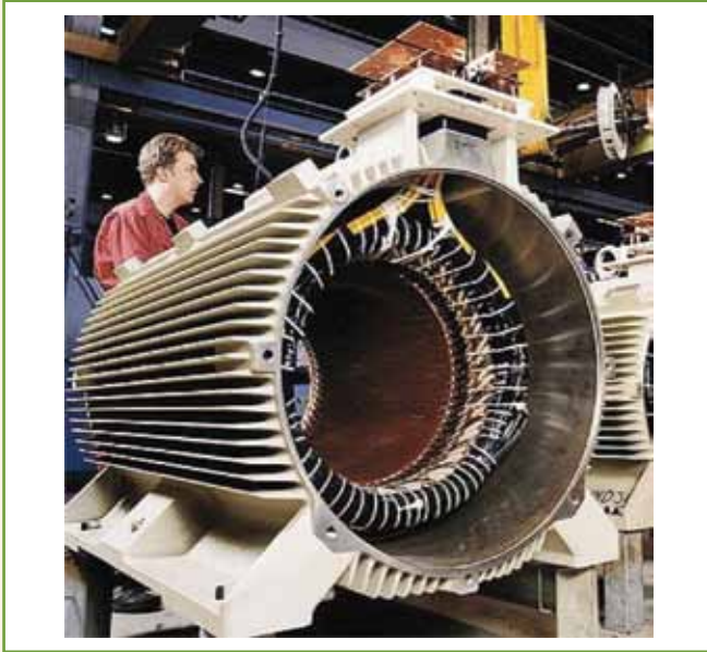
Figura 8 – Serviços de reparo de reenrolamento do estator de motor elétrico Ex “nA” com tensão nominal de 4.16 kV.
