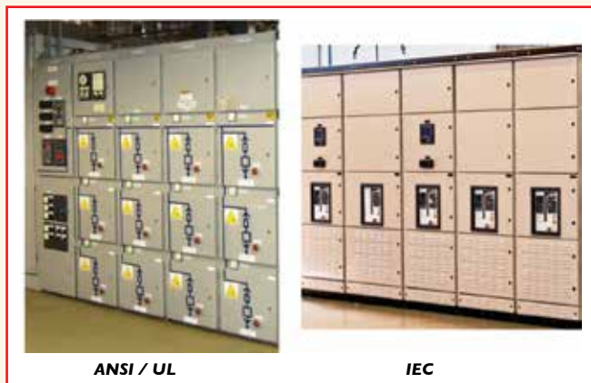
Figura 1 – Exemplos de formas construtivas de CDC de BT, conforme “escolas” norte-americana e europeia.
