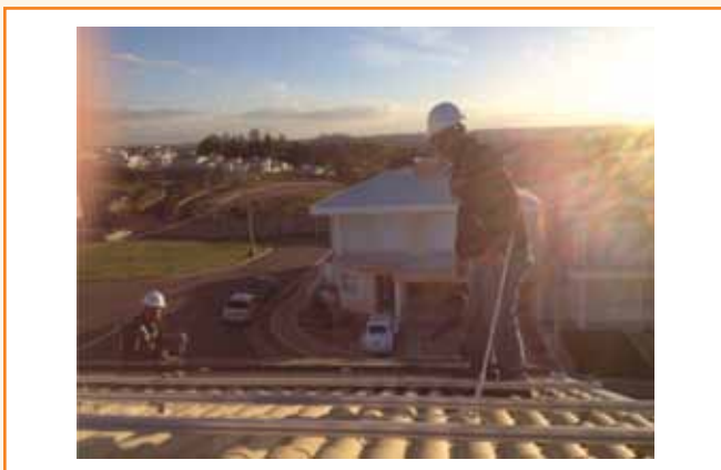
Figura 1 – Instalação de estruturas e módulos fotovoltaicos em sistema de microgeração residencial. Fonte: Eudora Solar.
