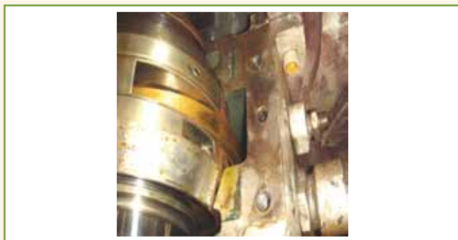
Figura 10 – Serviços de reparos em mancal de bucha de deslizamento autolubrificado com anel pescador em motor de indução trifásico “Ex”. Fonte: Petrobras.
