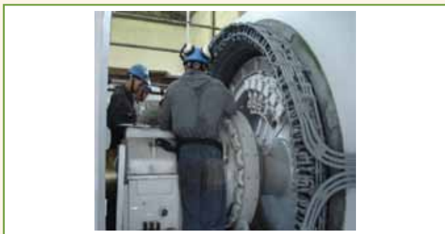
Figura 16 – Serviços de reparos em mancais de deslizamento e revisão de sistema de isolamento de motor síncrono do tipo “brushless”, com tipo de proteção Ex “nA”. Fonte: Petrobras/Refinaria Presidente Bernardes de Cubatão.
