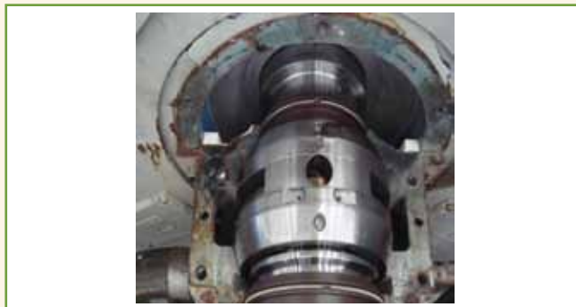
Figura 11 – Serviços de reparos em mancal de bucha de deslizamento com lubrificação forçada em motor de indução trifásico “Ex”. Fonte: Petrobras.
