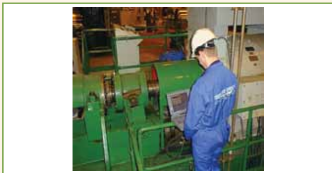
Figura 14 – Execução de serviços de medição e análise de vibrações para detecção de danos em mancais de rolamentos em motor de indução trifásico “Ex”, realizada por oficina de reparos certificada, em uma instalação em área classificada. Fonte: IECEx System – Karsten Moholt.
