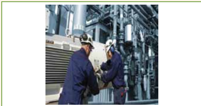
Figura 15 – Execução de serviços de campo para reparos em motor de indução trifásico certificado para atmosferas explosivas em oficina de reparos com certificação de conformidade. Fonte: IECEx System.
