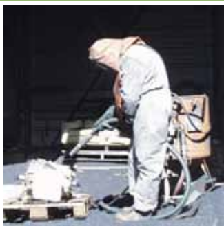
Figura 26 – Serviços de limpeza de carcaça de motor elétrico com jateamento com areia para permitir posteriores serviços de aplicação de sistema de pintura de proteção, com tintas de fundo, intermediário e de acabamento .
