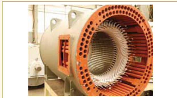
Figura 3 – Execução de serviços de reenrolamento do estator de motor de indução trifásico “Ex”, método de resfriamento IC511 – “Water jacket” (Fonte: Eletro Buscarioli).
