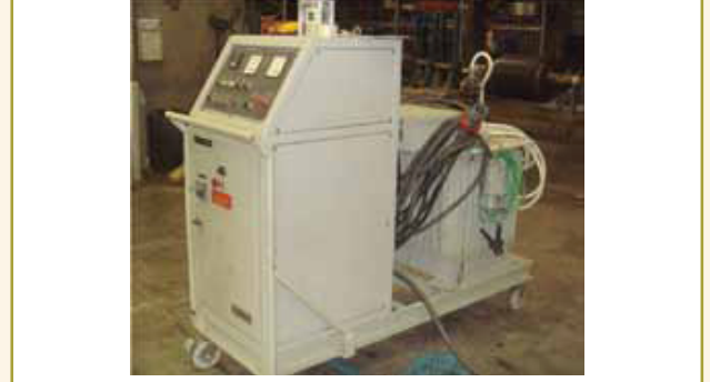
Figura 10 – Equipamentos para ensaio de tensão aplicada (“Surge Test”) após ensaio do tipo “spray-test” durante serviços de reparo em motor Ex “p” (Fonte: Petrobras).
