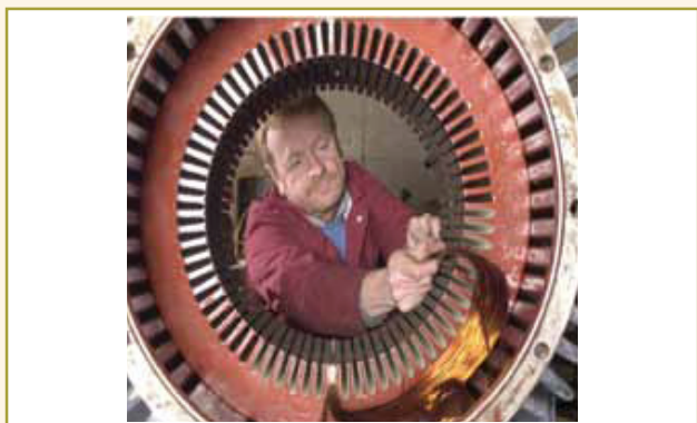
Figura 1 – Execução de serviços de reenrolamento do estator de motor de indução trifásico certificado para atmosferas explosivas em oficina de reparos com certificação de conformidade (Fonte: IECEx System / Kirkby Lindsey – UK)
