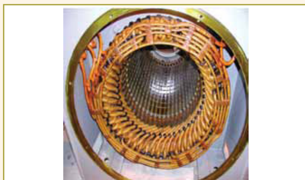
Figura 2 – Execução de serviços de reenrolamento do estator de motor de indução trifásico “Ex” (Fonte: Karsten Moholt – Noruega).
