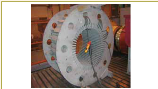
Figura 15 – Ensaio de fluxo requerido na NBR IEC 60079-19, realizado em pacote magnético das chapas do estator de motor elétrico “Ex” de 13,8 kV (Fonte: Petrobras).
