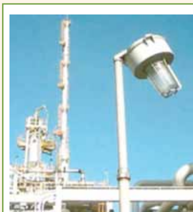
Instalação de luminária "Ex" com lâmpada do tipo vapor de sódio de alta pressão do tipo não acendível, com marcação "Ex nA II T4", EPL Gc. – Refinaria Presidente Bernardes de Cubatão
