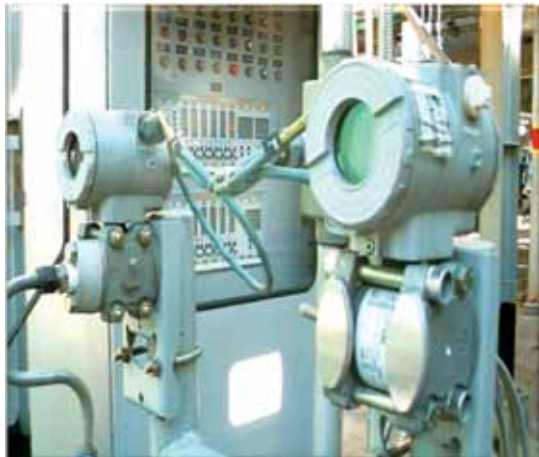
Instalação de transmissores “Ex” do tipo intrinsecamente seguros, com tipos de proteção “Ex ia IIC T5”, EPL Ga. – Refinaria Presidente Bernardes de Cubatão
