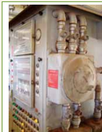
Instalação de painel local de controle “Ex” do tipo pressurizado com marcação “Ex pz d IIA T3” EPL Gc. – Refinaria Presidente Bernardes de Cubatão
