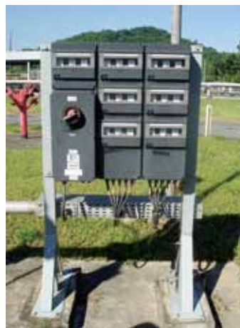
Instalação de painel de distribuição de circuitos de força “Ex”, do tipo à prova de explosão e segurança aumentada, com tipos de proteção “Ex de IIC T4”, EPL Gc. – Refinaria Presidente Bernardes de Cubatão
