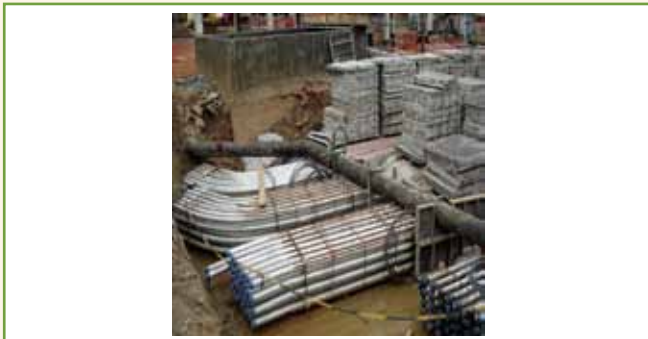
Figura 14 – Sistema de eletrodutos subterrâneos, em fase de construção, para circuitos e sistemas elétricos e de instrumentação instalados em áreas classificadas. Estes eletrodutos interligam, de forma adequada, os equipamentos “Ex” instalados em áreas classificadas, com áreas seguras onde estão instalados painéis do tipo CCM, tais como subestações elétricas e painéis do SDCD/PLC/PES em casas de controle locais.
