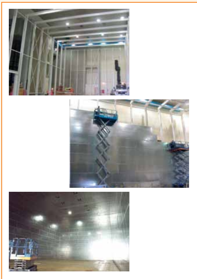
Figura 4 – Construção de sala blindada modular
