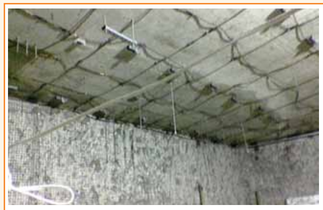
Figura 6 – Tela metálica na parede e malha no teto
