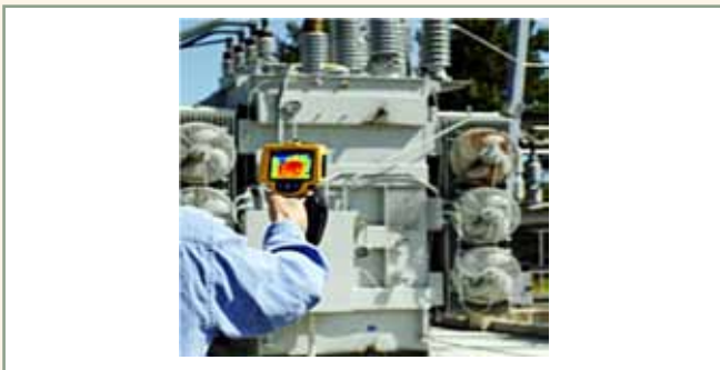
Figura 6 – Análise feita com o termovisor em atividade
