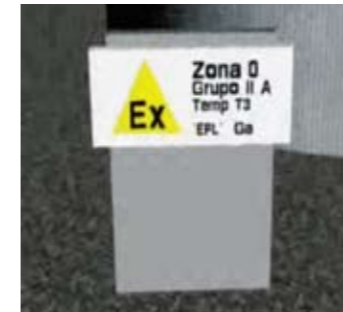
Placa de sinalização de área classificada contendo atmosfera explosiva de gás, com indicação de zona 0, grupo, classe de temperatura e EPL Ga requerido para os equipamentos elétricos e de instrumentação a serem instalados neste local
